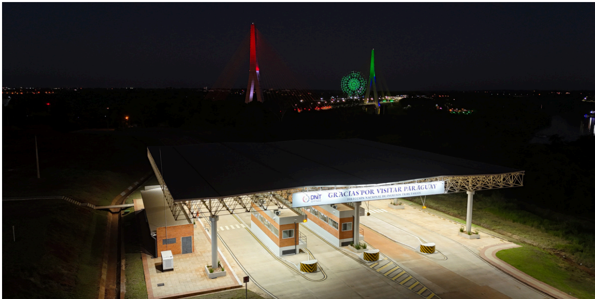
3. Con la habilitación, iniciaron las operaciones del centro de frontera del Puente de la Integración, lado paraguayo.
