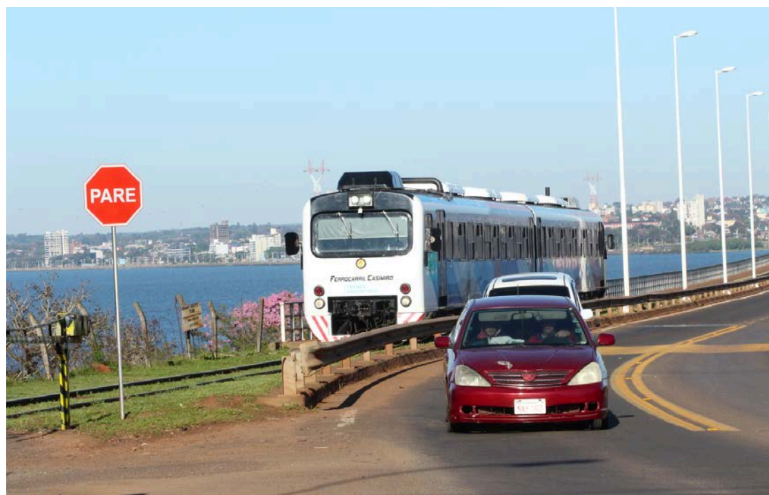
1. Puente Internacional San Roque González de Santa Cruz, frontera Encarnación - Posadas. Agosto 2025.
